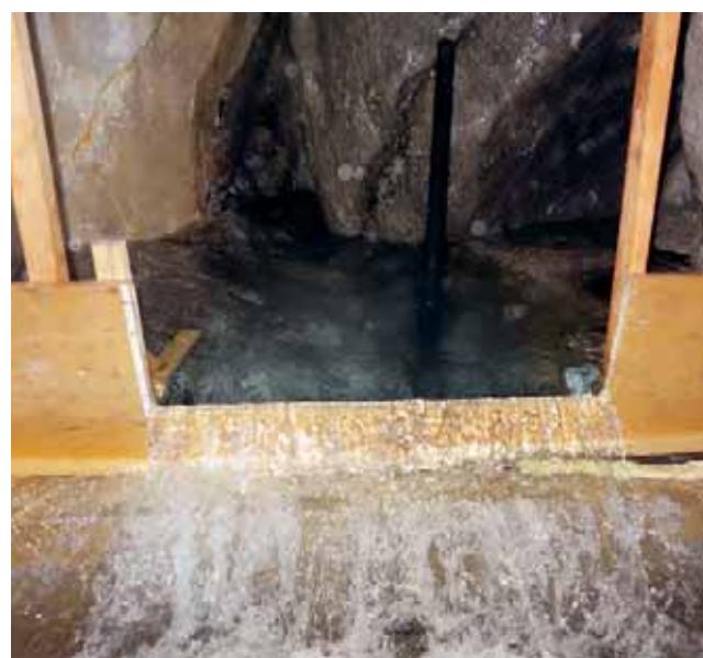
Misura portata della presa numero 1 a Peccia.
